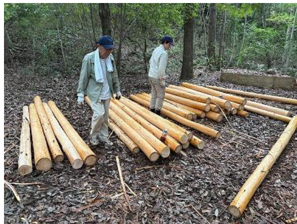
この丸太すべて剥きました！この後、製材して階段の部材にします。
