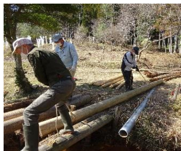
丸太をロープで引っ張り橋に渡す
