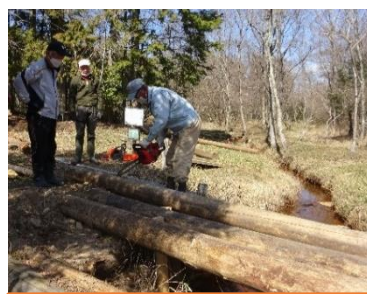
チェーンソーで丸太の長さを揃える
