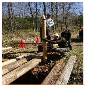
杭を打ち込み長さを揃える
