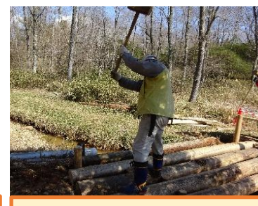
杭を打ち込みすべての橋げたを固定
