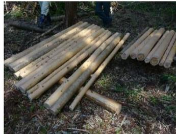
橋の修理で杭に使うため檜を4本除伐。幹の太い部分は5メートルの長さに切り、皮むきをする。細い部分は2メートルの長さに切り、皮をむいて護岸用の杭に使うことにした。
